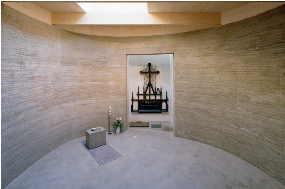
Versöhnungskirche Berlin. Tragende Wände und Fußboden aus Stampflehm (Bild: Bruno Klamfar, Architektur Rudolf Reitermann und Peter Sassenroth, Ausführung Lehm Ton Erde Baukunst GmbH).
