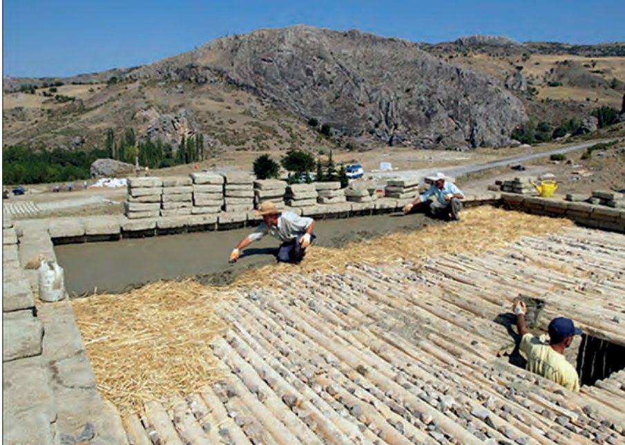
Verlegen von Lehmestrich nach der nassen Methode. Boğazköy-Hattuša (Bild: Archiv der Boğazköy-Expedition des Deutschen Archäologischen Instituts [Jürgen Seher]).
