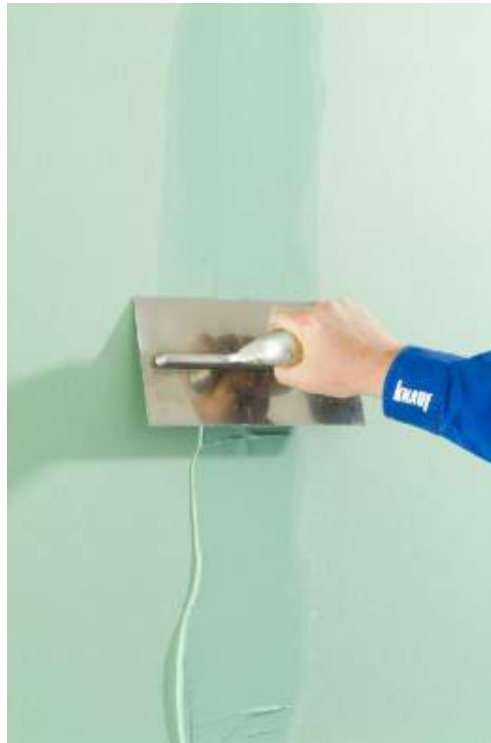
Füllen und eben abziehen
