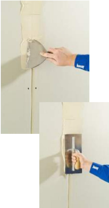
Füllen, quer zur Fuge
