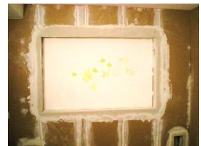
Schritt 10 – Fugen und Übergänge verspachteln
