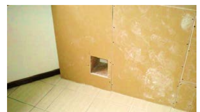
Schritt 8 – montierte Vorsatzwand um die beiden Steckdosen-Koffer und vor der zu kaschierenden Säule
