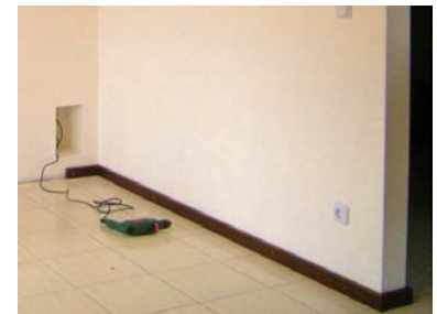
Schritt 10 – finale Arbeiten vor dem Putzen und Einräumen
