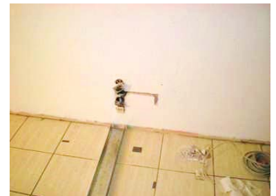
Schritt 3 – Steckdosenaussparung (Bodenprofil liegt hier noch falsch)
