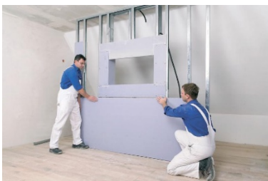
Trockenbau ist schnell und kostengünstig realisierbar.
