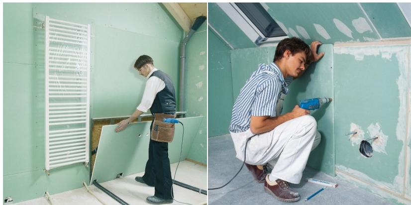
Knauf Gipskartonplatte GKBI imprägniert Maße: 2000 x 1250 mm - Stärke: 12,5 mm
