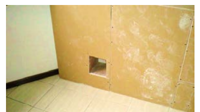
Schritt 8 – montierte Vorsatzwand um die beiden Steckdosen-Koffer und vor der zu kaschierenden Säule
