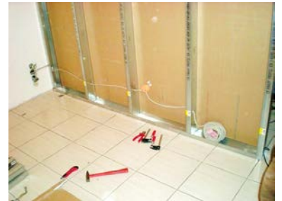
Schritt 6 – Platten auf einer Seite montiert, Elektroinstallation am Platz
