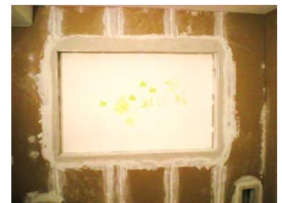
Schritt 10 – Fugen und Übergänge verspachteln
