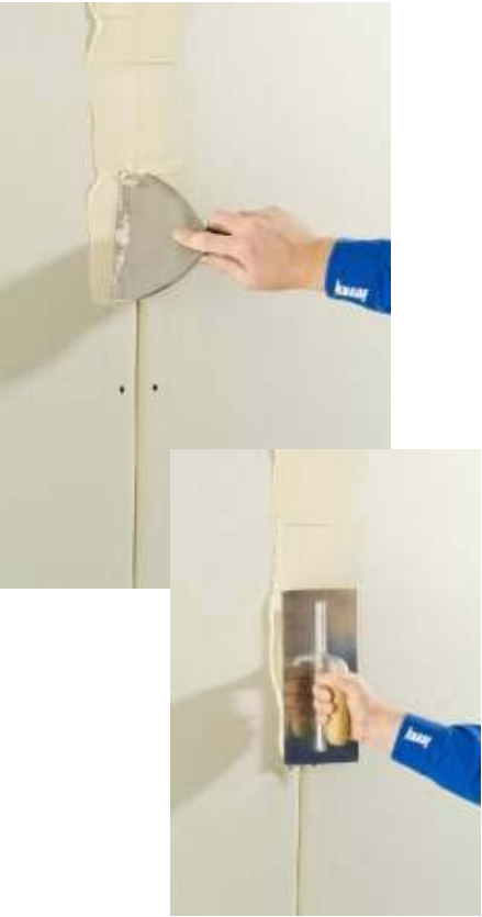
Füllen, quer zur Fuge
