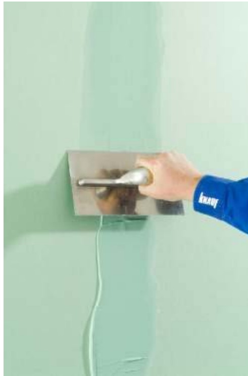
Füllen und eben abziehen
