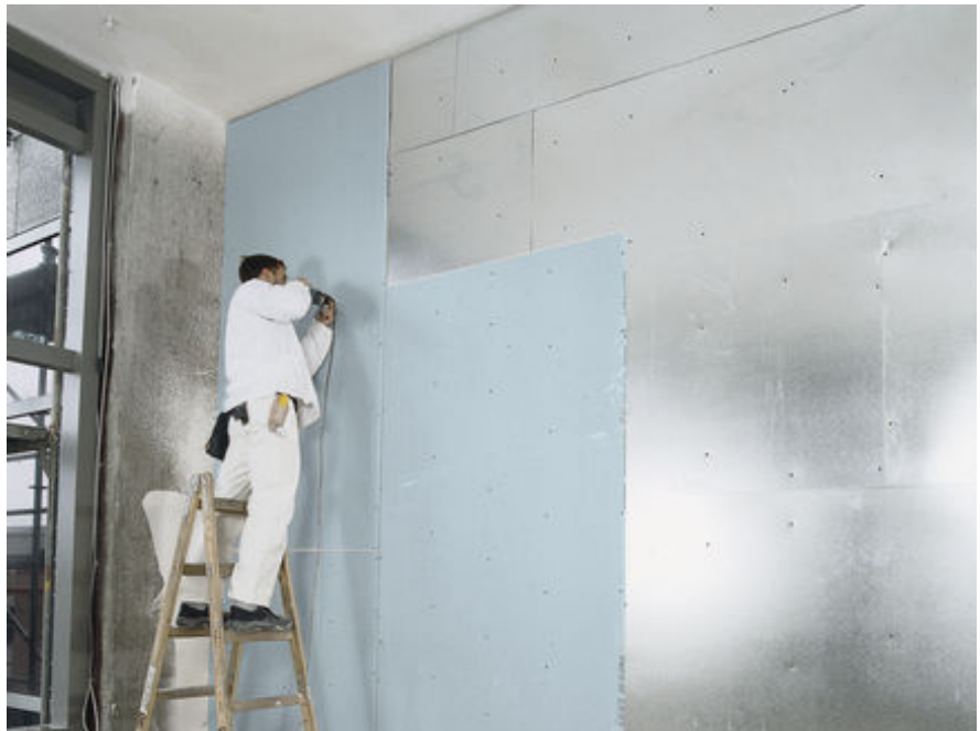
Knauf Sicherheitswand - einbruchhemmend Montagewände mit Unterkonstruktion aus Stahlblechprofilen und beidseitiger Beplankung aus Gipsplatten und Stahlblech
