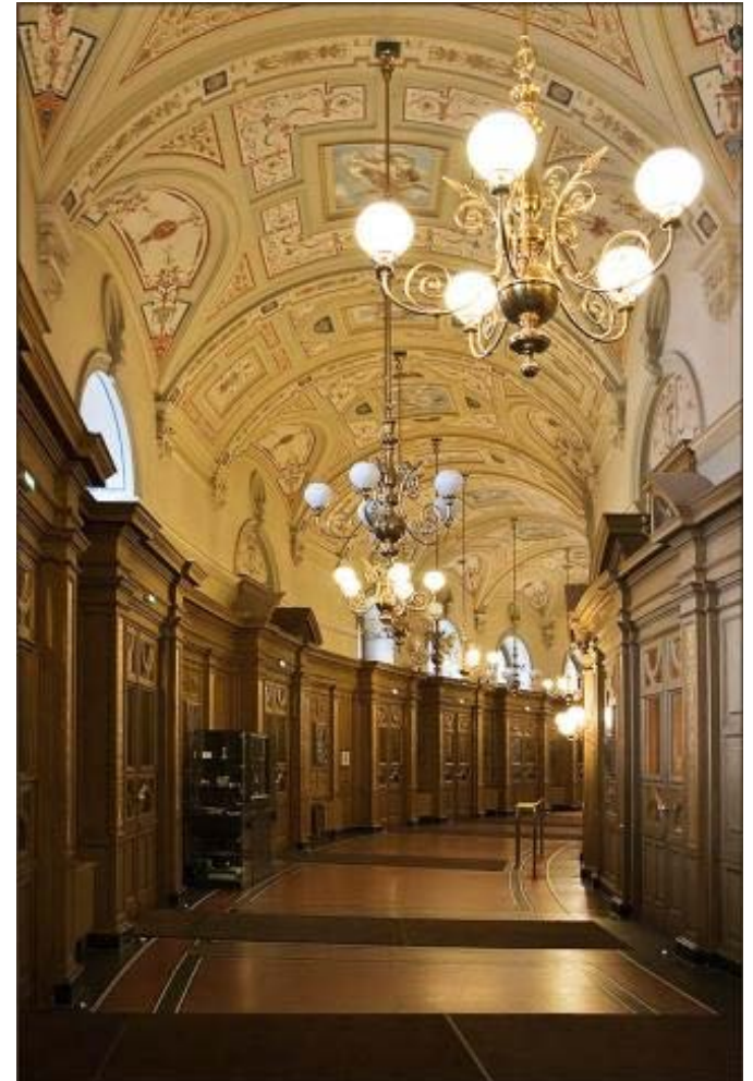
Semper Oper in Dresden Gips als Holzvertäfelung
