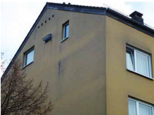
Bild 15–18: Algen gibt es auch auf ungedämmten Fassaden
