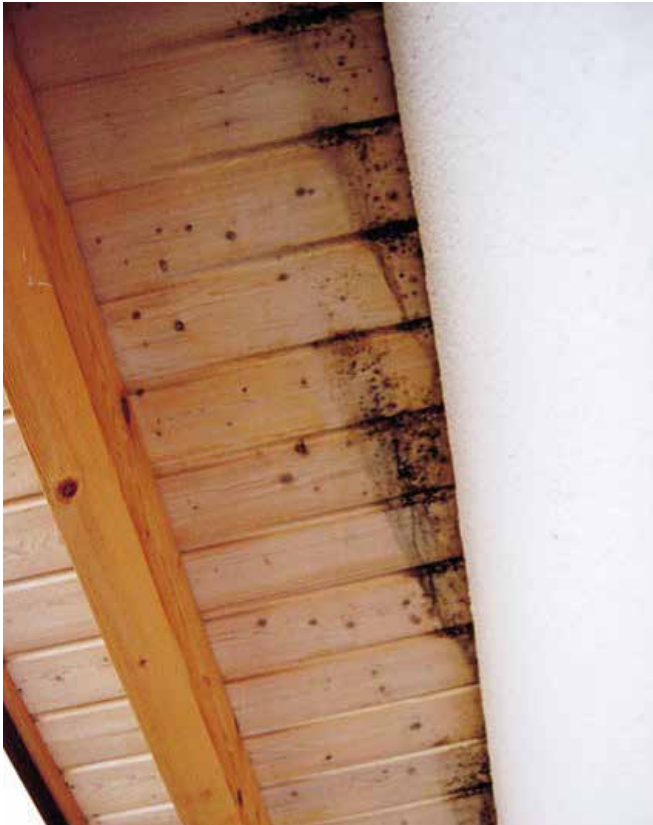
Bild 9: Dachüberstand außen an der Dachwohnung
