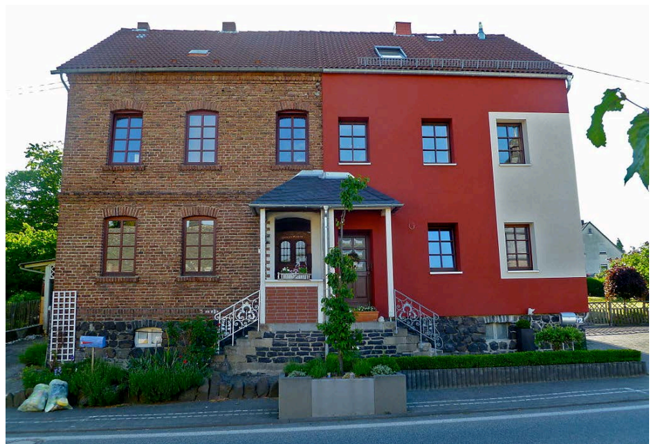
Rechter Teil der Fassade mit WDVS saniert.
