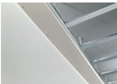
Abgehängte Decken mit Schallschutz
